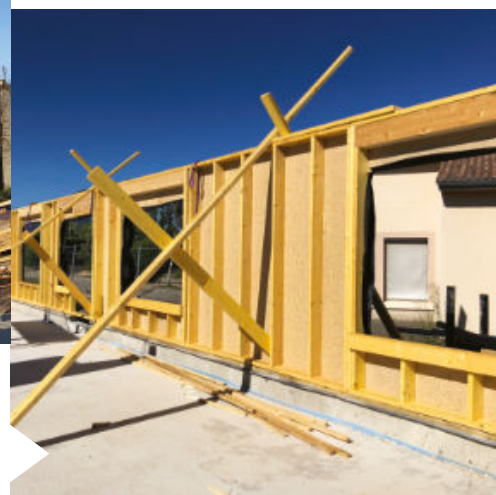
Construction en matériaux durables, ossature bois en cours d'édification
